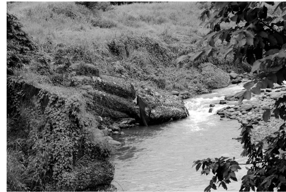
Uno de los gaviones caído tras de las primeras lluvias, agosto de 2022
