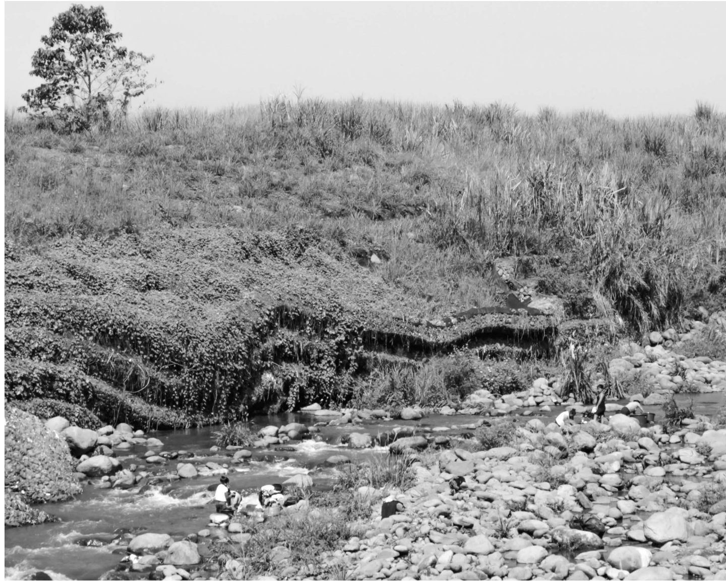
Mujeres lavando su ropa en el río Sis, contaminado por los desechos de dos ingenios cercanos. Además se enfrentan al peligro de la caída de los gaviones cuando lleguen las lluvias fuertes del invierno y los ingenios suelten el exceso de agua de las represas, marzo de 2022.
